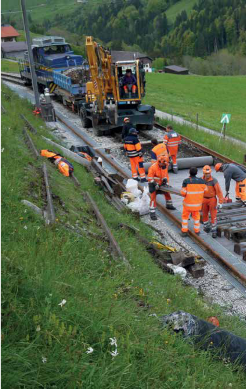
Réfection de la voie Les Cases – Allières
